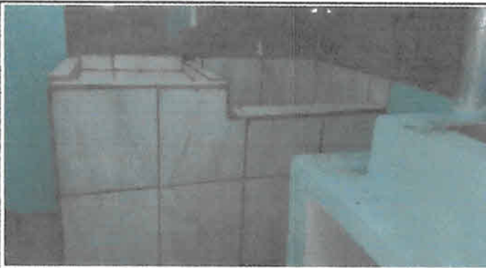
Foto 3: Puesta de cerámico a la pila de la cocina.
