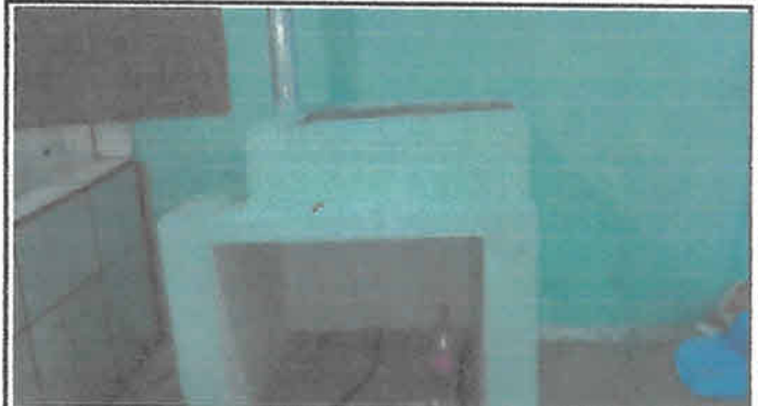
Foto 2: Reparación de estufa rural con chimenea con monocapa blanco y pintado.
